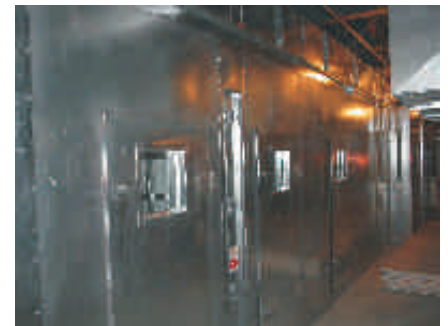
CHAMBRE MÉCANIQUE CVAC
