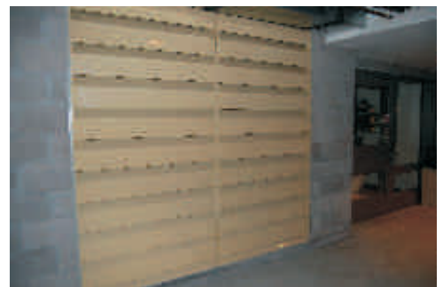
PERSIENNES ACOUSTIQUES ARCHITECTURALES INSTALLÉES
